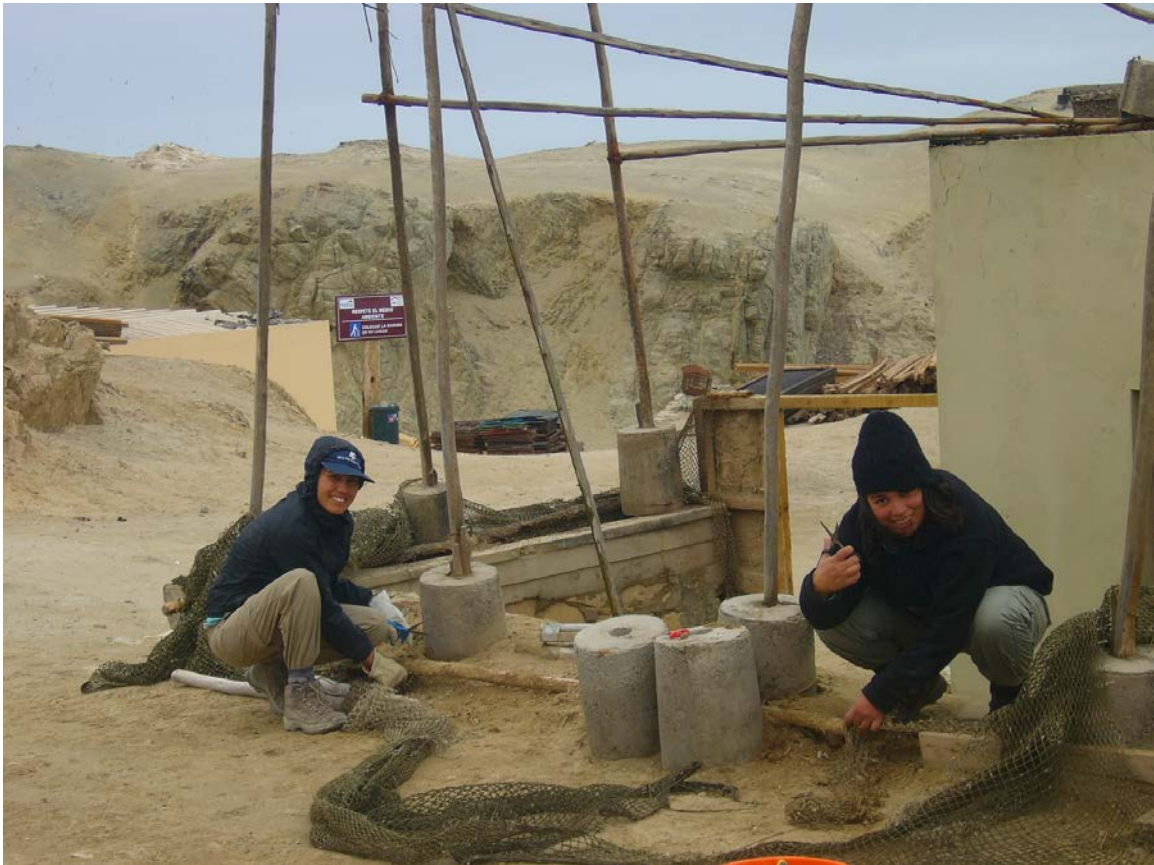
Fotografía 27. Voluntarios ayudando a reparar la estación de campo en Punta San Juan.
