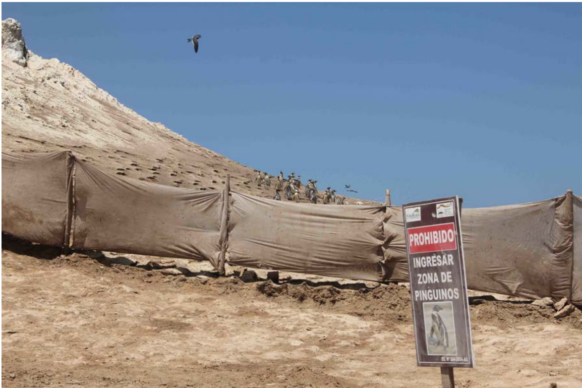
Fotografía 10. Señal advirtiendo a los trabajadores que está determinadamente prohibido que ingresen al área de los pingüinos.
